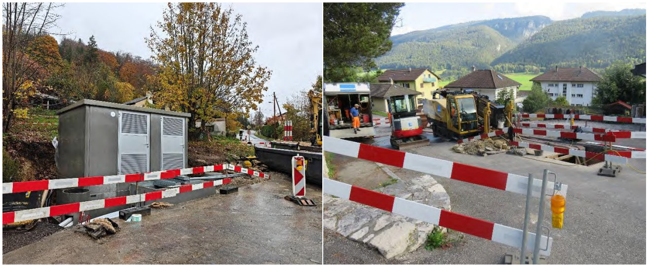
Route de Tramelan : Nouvelle station transformatrice Paul-Charmillot. Forage dirigé entre les rues Champs-Meusel et Paul-Charmillot
