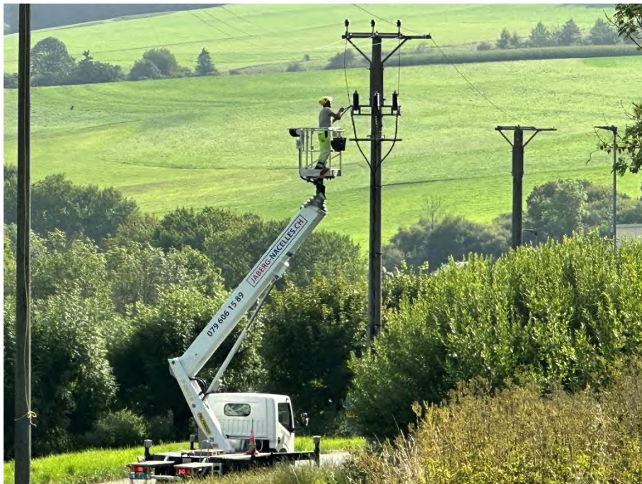
Electricité : Démontage de la ligne Sud MT
