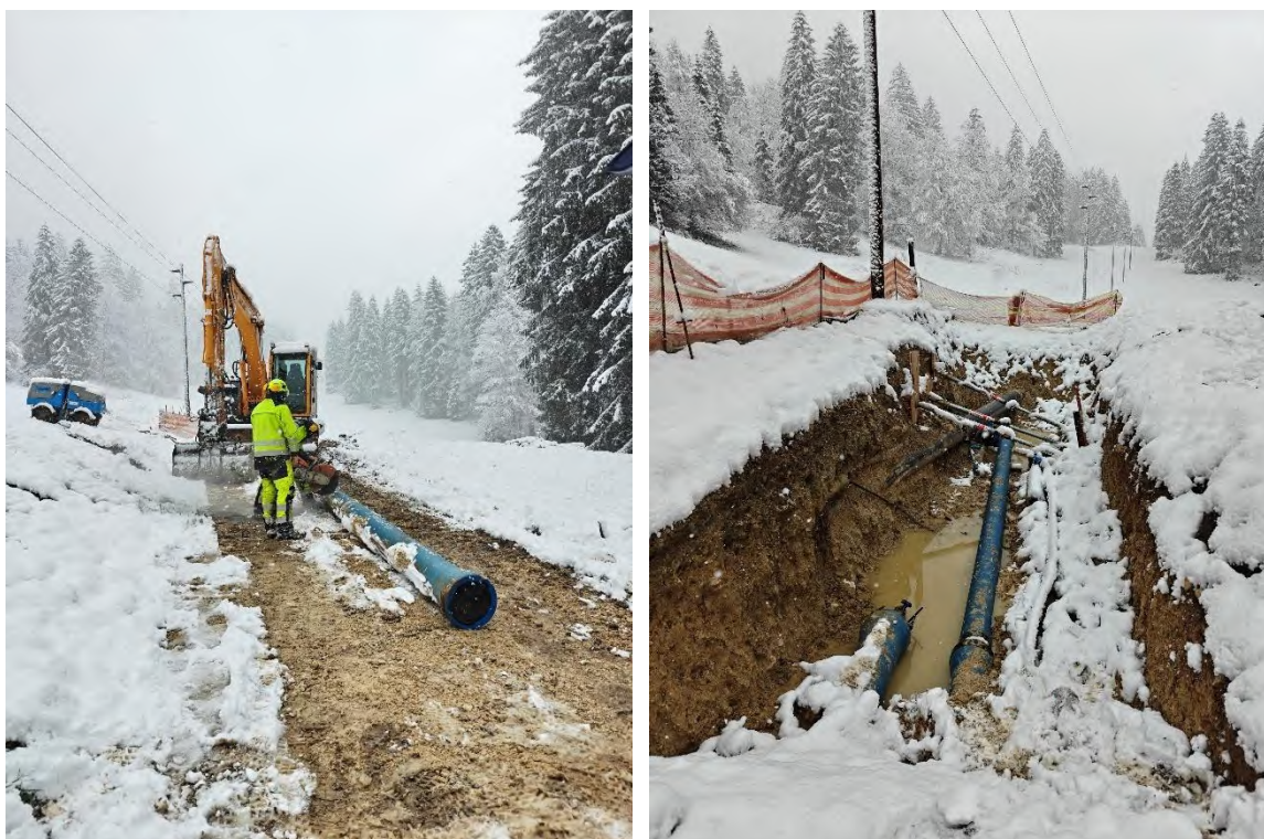
Renouvellement de 1200 mètre de conduite de transport entre Cormoret et Saint-Imier).
