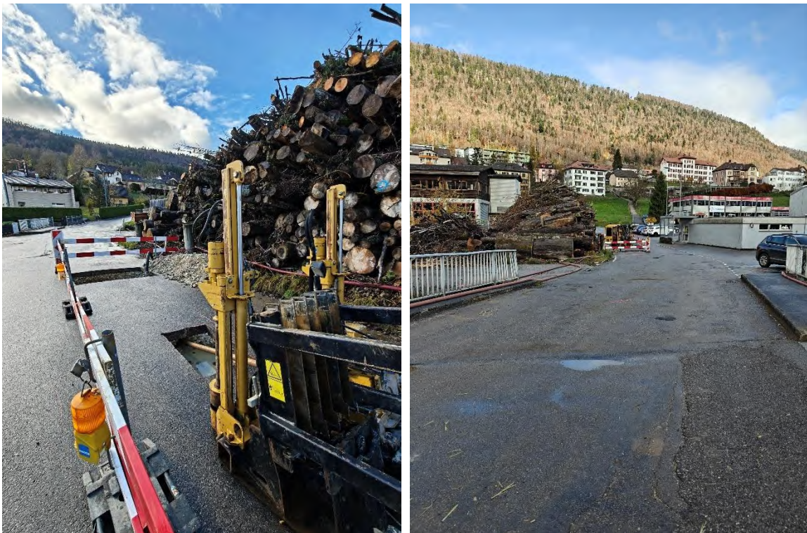
Mise en place de conduites de part et d'autre de la Suze par forage (Rue du Pont).
