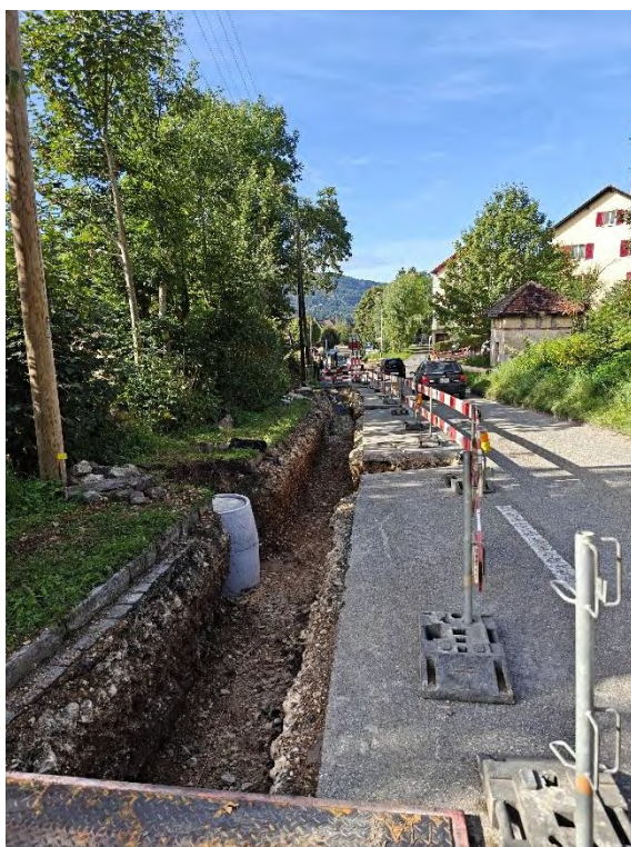
Route de Tramelan, renouvellement du réseau et pose de conduites supplémentaires
