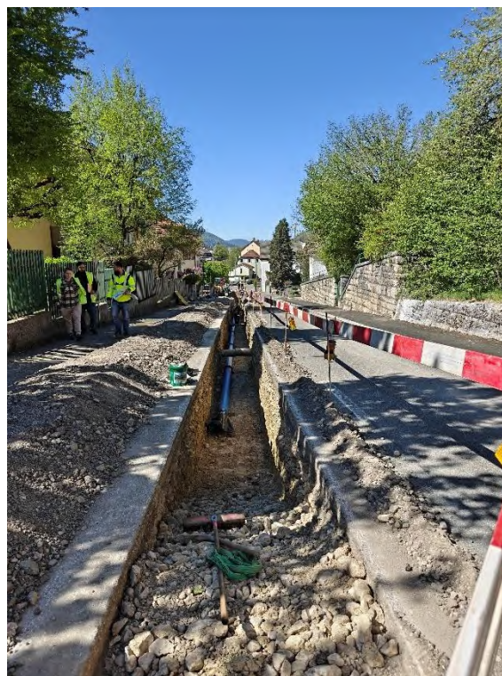
Route de Tramelan, renouvellement du réseau et pose de conduites supplémentaires
