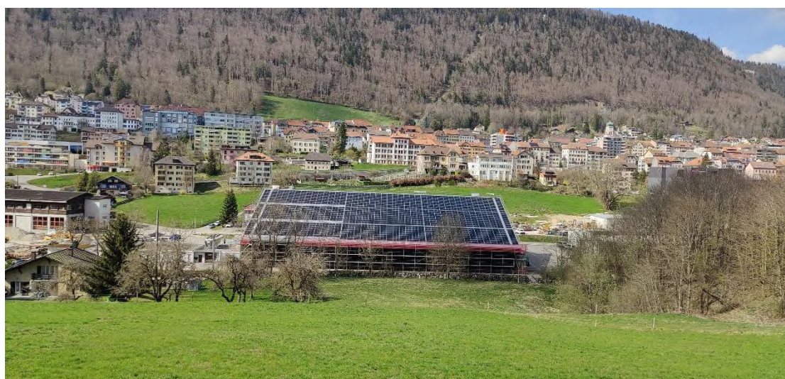
Toit de la Clientis Arena mise en service en juillet 2025
