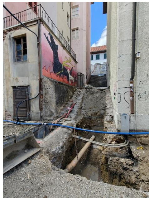
Préparation de l'installation du nouveau collecteur d'eaux claires dans les escaliers entre Francillon 26 et le 28 (août 2026)
