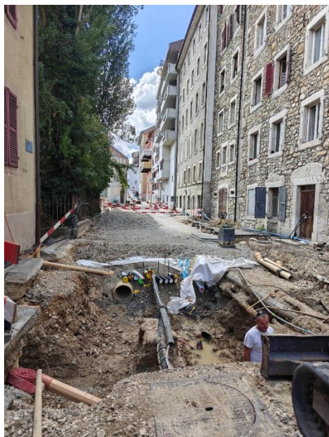
Mise en place d'un nouveau collecteur d'eaux claires à la rue Basse et rénovation des réseaux (août 2026)
