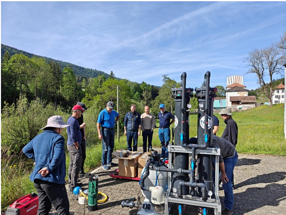
L'unité de traitement d'eau par ultrafiltration et des experts du Corps suisse d'aide humanitaire de la Confédération.
