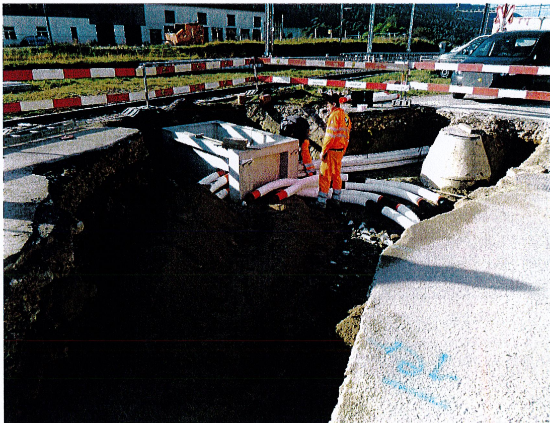
Pose de tubes électriques à la rue de Chasseral.
