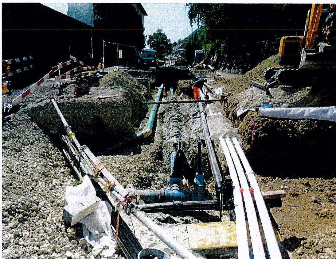
Travaux à la rue Paul Charmillot (sept. 2021).
