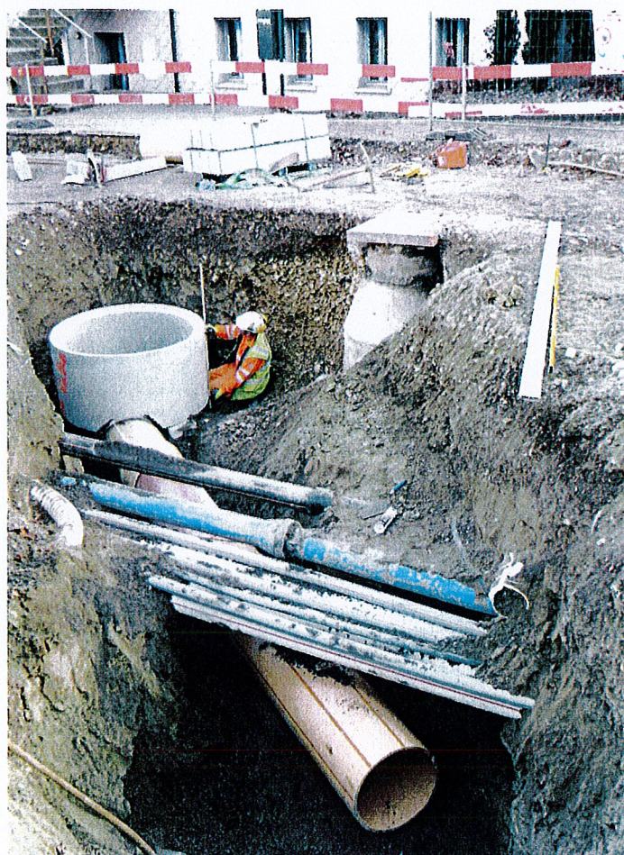
Rue du Vallon, chambre et nouveau collecteur d'eaux claires (diamètre 400 mm) sous la batterie des autres réseaux souterrains (eau électricité, gaz, téléseau).
