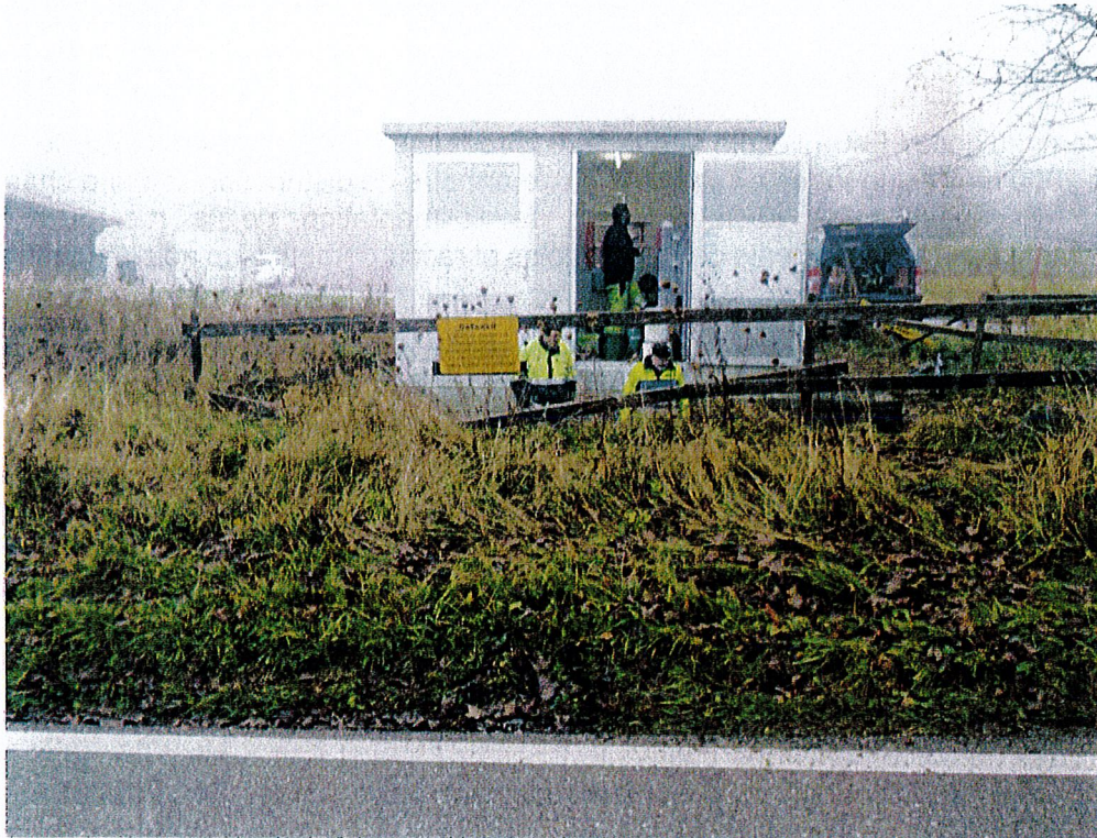
Mise en service de la station Sava 4 (automne 2021)
