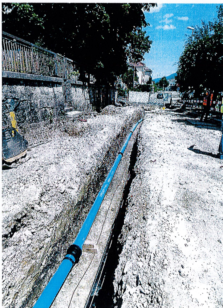
Renouvellement de la conduite d'eau à la rue du Vallon.
