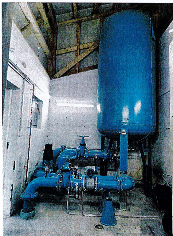
Station de la Raissette, équipement anti coup de béliet (mise en service en automne 2021)
