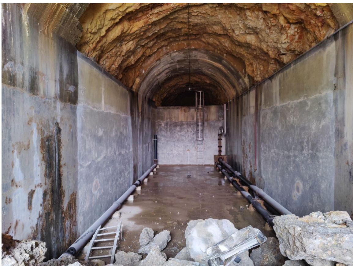
Réservoir Sur les Crêts 1893, état avant les travaux (février 2024)
