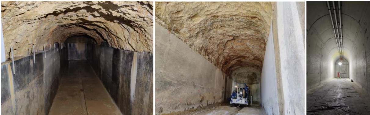
Le réservoir situé sur les Crêts avant, pendant et après sa rénovation.
