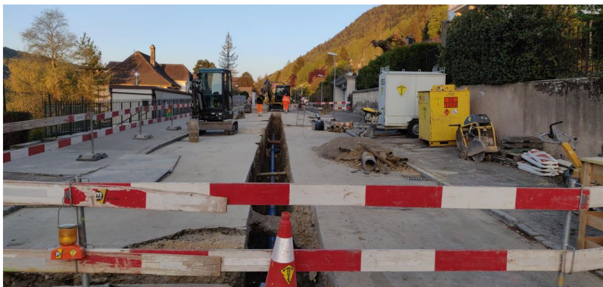
Près de 200 mètres de tuyaux ont été remplacés à la Rue de la Fourchaux.
