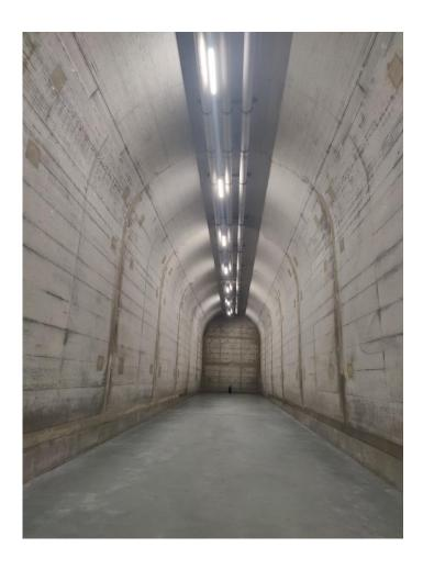
L'ancien ouvrage taillé dans le rocher a été complètement bétonné en utilisant une technique élaborée pour les tunnels. La voûte en calcaire apparent a été également étanchéifiée avec un béton accrédité pour les ouvrages destinés au stockage de l'eau potable afin d'éviter les infiltrations d'eau.
