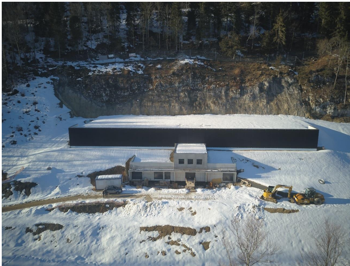
Vue aérienne du réservoir des Philosophes.
